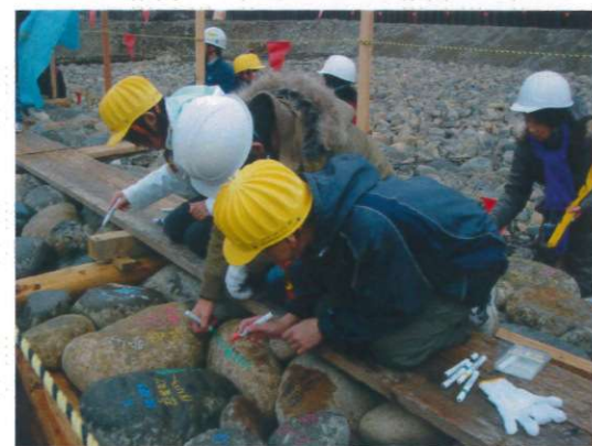
施工現場が子ども達の環境学習の場として利用されています。
