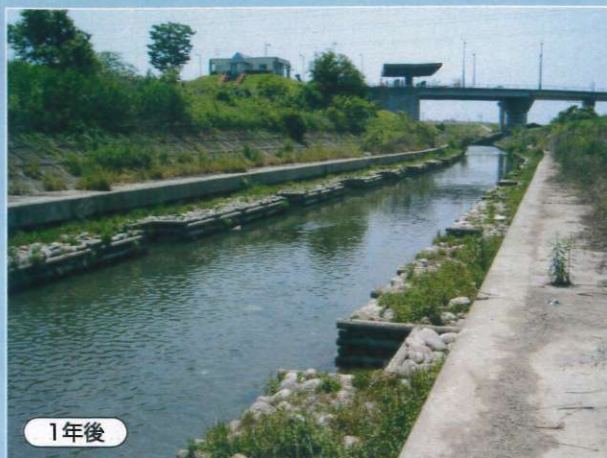
矢板護岸の前面に「お魚のゆりかご」を配置した事例。「ピオクロス」との組み合わせによりワンドを創出。
