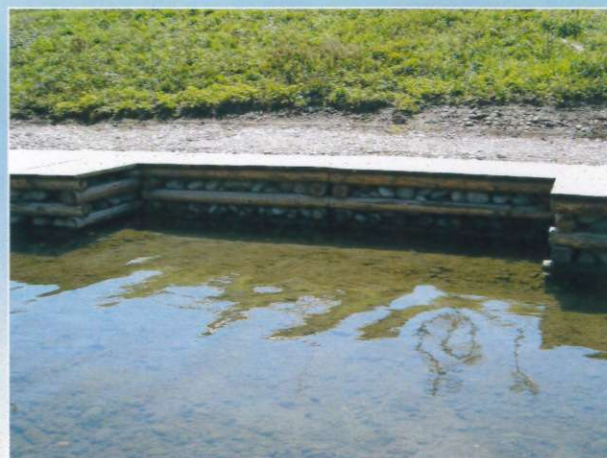
矢板護岸の前面に「お魚のゆりかご」を配置した事例。「ピオクロス」との組み合わせによりワンドを創出。
