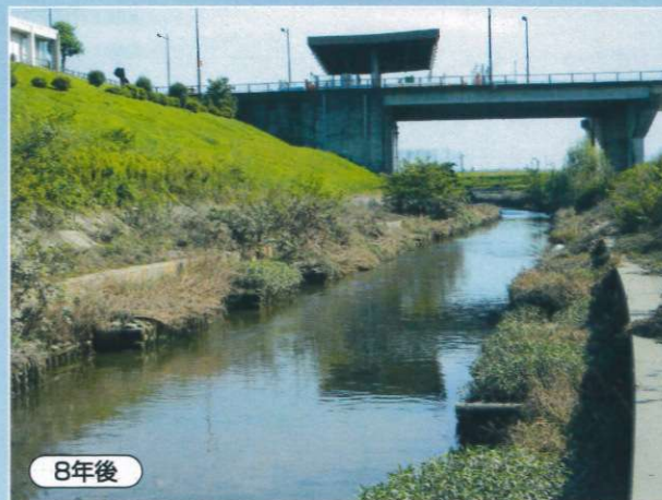
矢板護岸の前面に「お魚のゆりかご」を配置した事例。「ピオクロス」との組み合わせによりワンドを創出。
